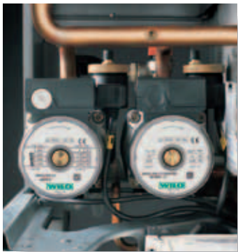
Два насоса, предназначенные для отопления и загрузки бойлера со встроенными воздухоотводчиками
