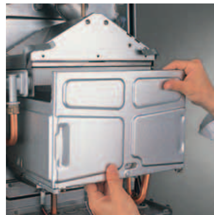
Открытие камеры сгорания (на защелках)
