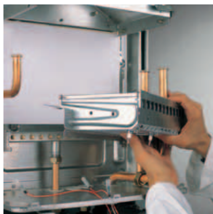
Демонтаж горелки выдвижением вперед без отключения подачи газа
