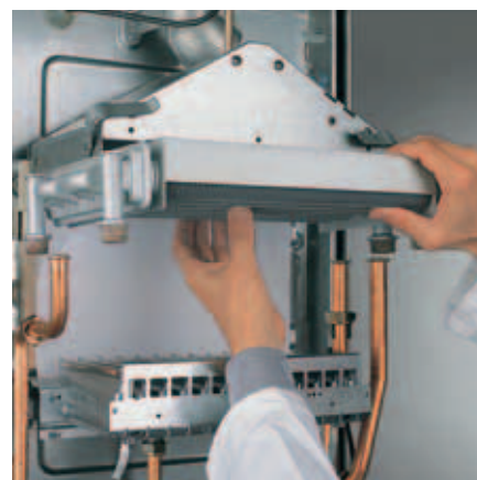
Демонтаж теплообменника выдвижением вперед
