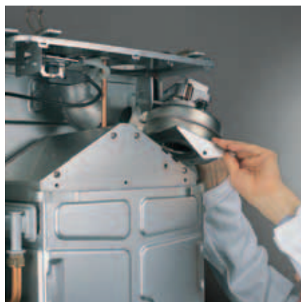
Демонтаж вентилятора (необходимо открутить 1 винт)
